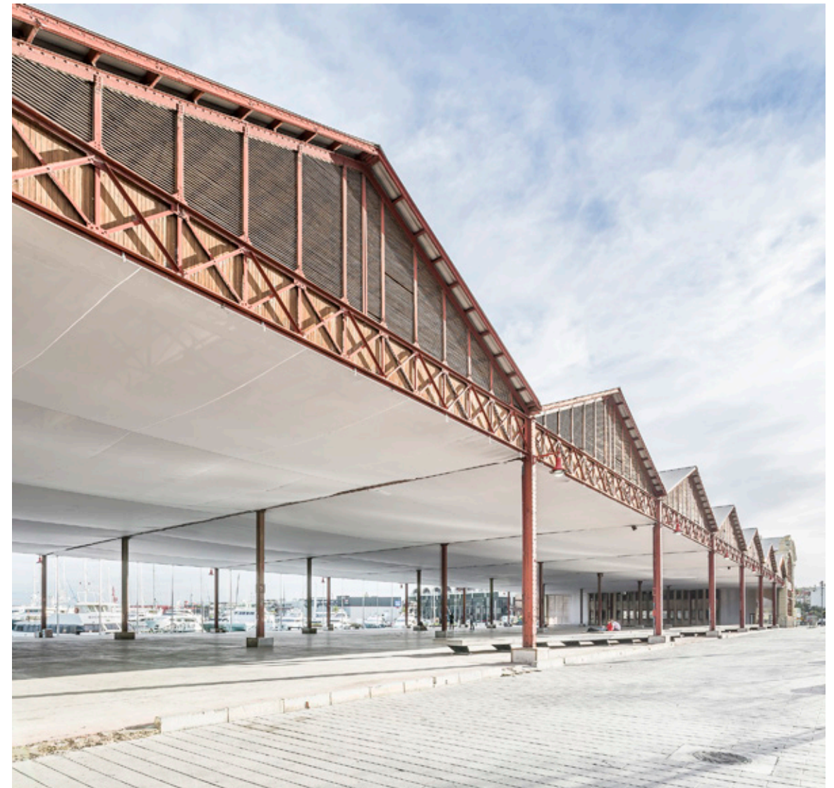
figura 1 Tinglado 2 RELLAM (Imagen cortesía de RELLAM)
