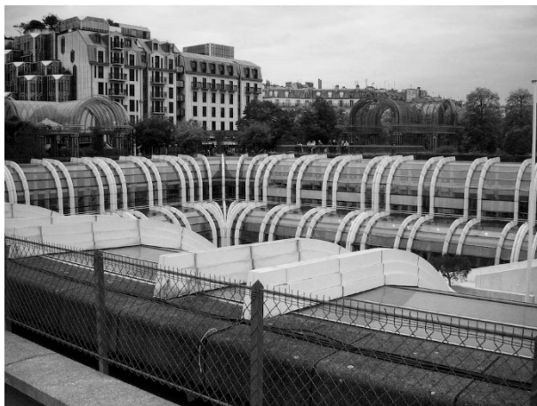
Figura 1: Les Halles, 2009, foto del autor
