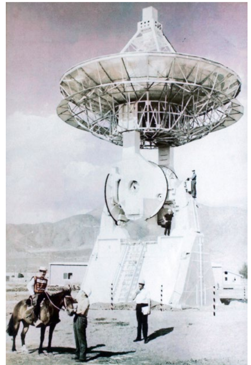
figura 3 Huaso chileno, junto a una anayena de 40 pies de diámetro en la estación de seguimiento de satélites de la NASA. Peldehue, Chile, c. 1966. Fuente: Corporación Espacial Sueca (SSC).
