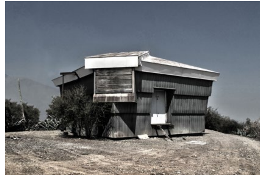
figura 8 Domo del Gran Instrumento de Pasaje (GIPP), diseñado por Yuriy Streletskiy. La estructura fue prefabricada en San Petersburgo y ensamblado en Cerro Calán en 1966 bajo la supervisión de Streletskiy.
