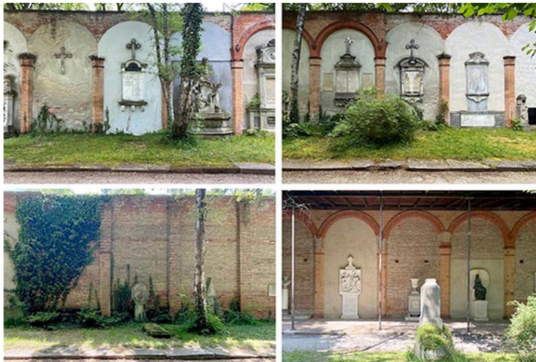
Figura 11: Muro consolidado de las nuevas arcadas. Fuente: elaboración propia, 2023.
