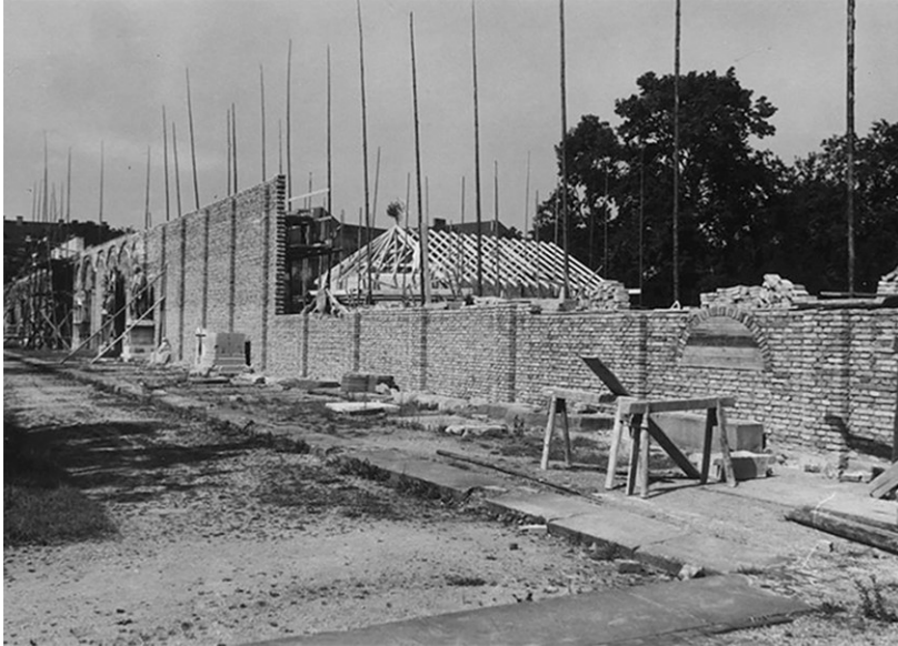
Figura 9: Reconstrucción del cerramiento de las nuevas arcadas en el tramo más afectado, con la nueva cubierta del lapidario al fondo. Autor desconocido. 9/3/1953. Stadtarchiv München, signatura DE-1992-FS-NK-STB-0038.
