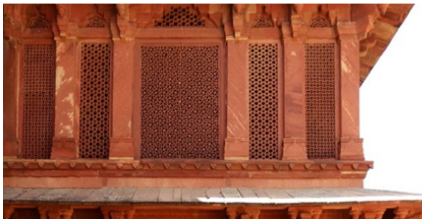
Figura 3: Vista de las celosías de piedra en la casa de Raja Birbal. Fotografía de autores del artículo.
