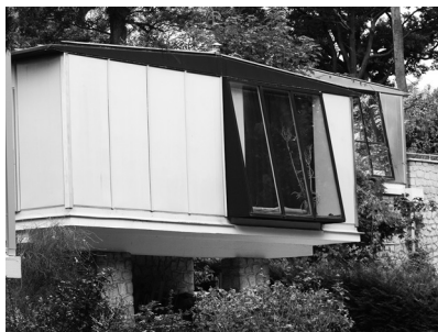
[foto 3] Pórtico central de chapa de acero.
