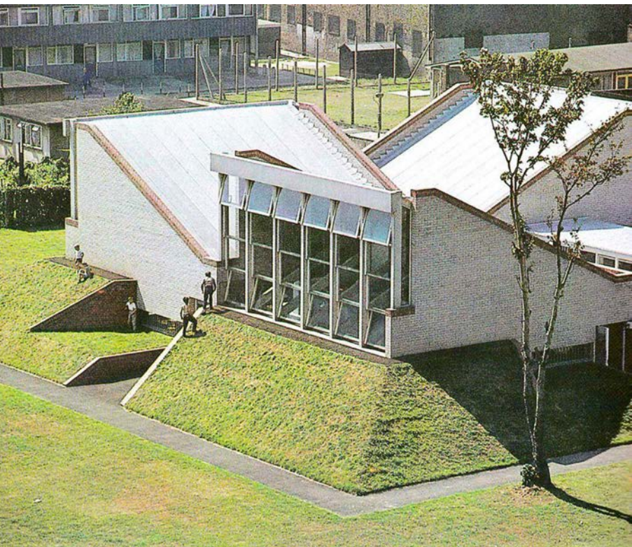
figura 20 Exterior view of assembly and dining hall for Brunswick Park Primary School, Camberwell, London. En STIRLING, J., WILFORD, M., 1985. James Stirling: obras y proyectos. Barcelona: Gustavo Gili. Pág. 78
