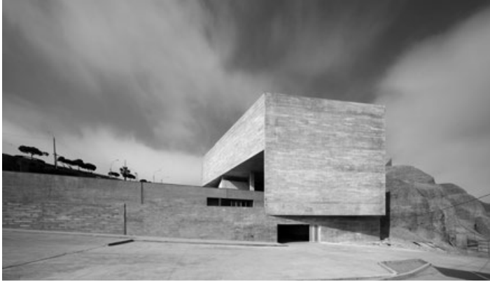
Izquierda, fachada del Lugar de la Memoria hacia el mar. Último módulo de una secuencia de farallones. Abajo, alzado longitudinal, acceso a plaza dura inferior.
