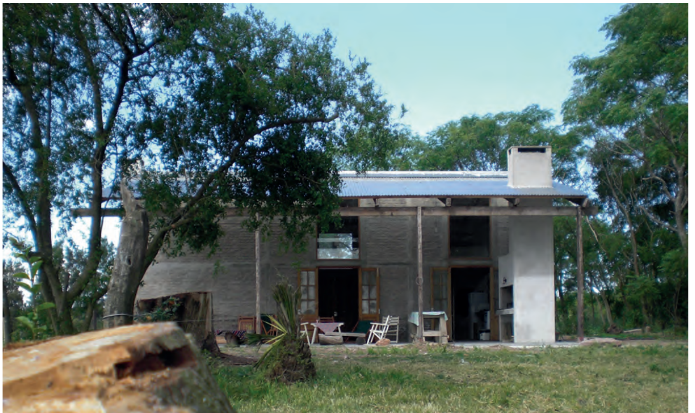
Transformación de la antigua bodega en un espacio flexible destinado a convertirse en un refugio y un lugar de encuentro. El edificio existente brinda las pistas necesarias sobre la materialidad y el carácter de la nueva intervención.
