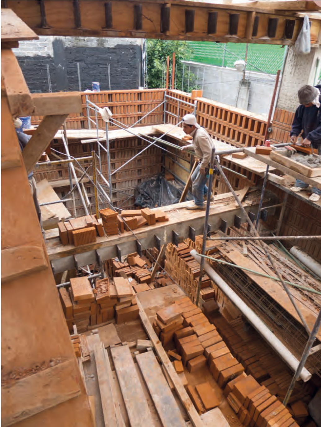
Proceso de construcción y aparejo de los muros del Estudio Iturbide donde se puede apreciar la varilla en espera que arma verticalmente el lienzo.
